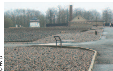
3. Le crématoire et la tour de garde est.
